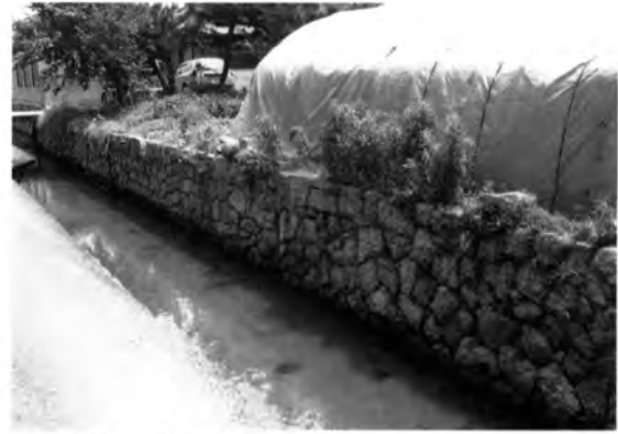
第8図版 桜川と屋敷地東側の石垣（北東から）
