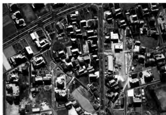
第57図版 区画道27号線空撮
