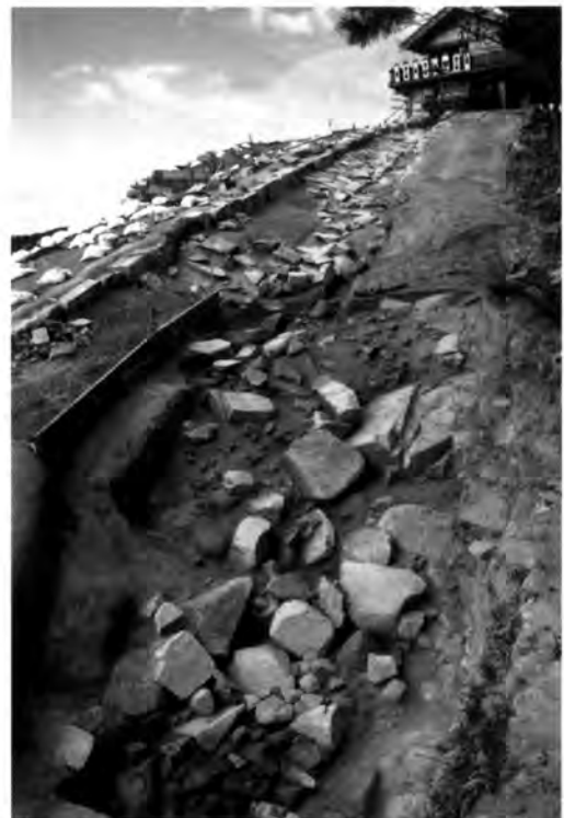
第78図版 土留め石列 (東から)
