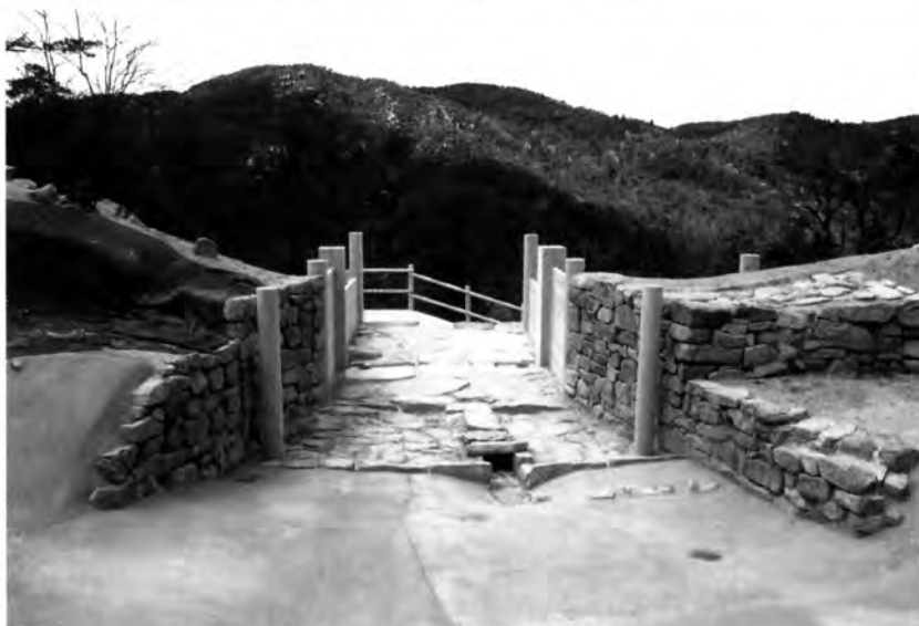
第92図版 表示整備後の北門（東から）
