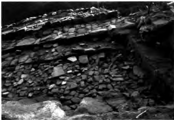
第76図版 城内側敷石 (北から)
