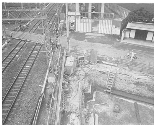
南海本線佐野4号踏切周辺(東→南西方向)
