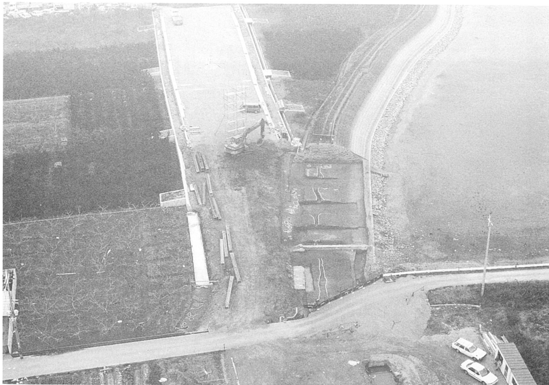
二俣池西側堤防調査区遠景（南から）
