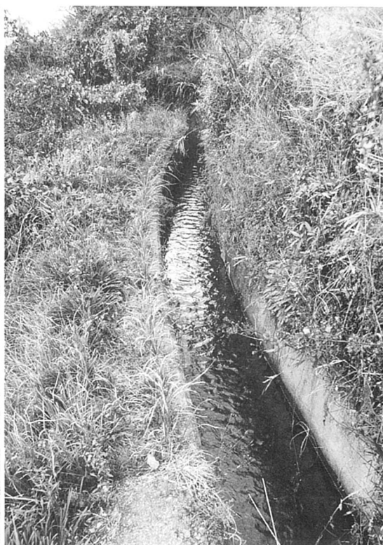
上原水路 (北から)
