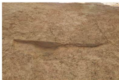
SD4 ベルト② (西から)
