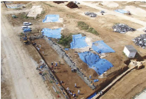
工区1 全景 東から
