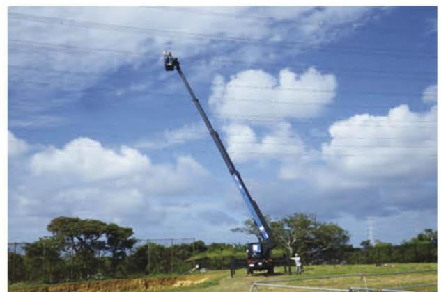
完掘状況撮影
