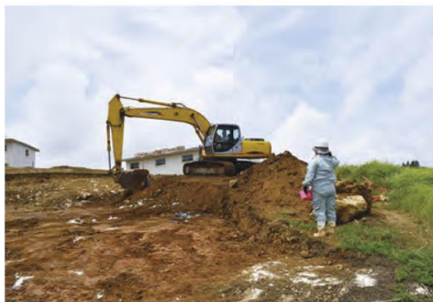
工区1 表土掘削
