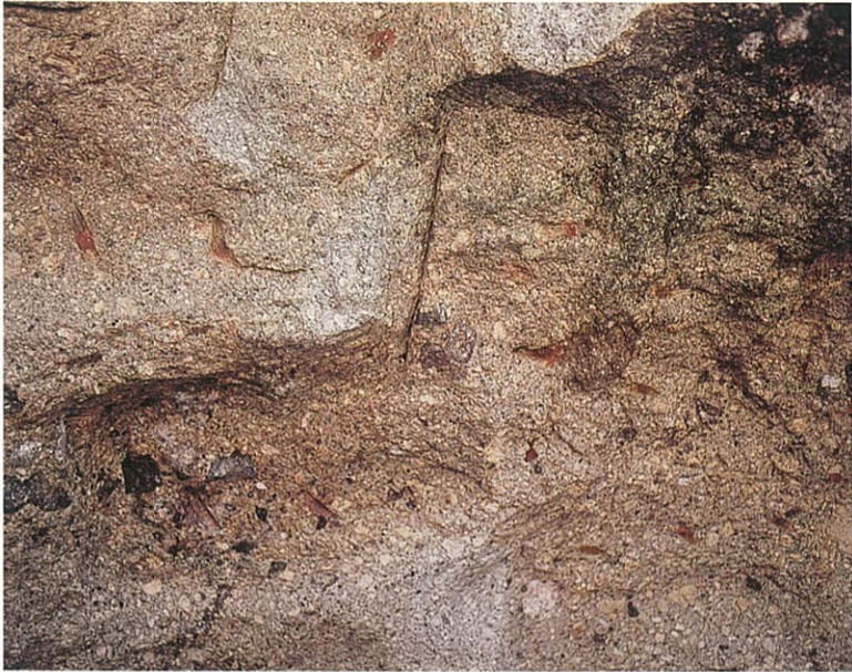
15. L字形の採石痕 (No.274) と工具痕
