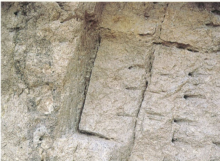
19. 長方形の採石痕 (No.413 · 415) と工具痕
