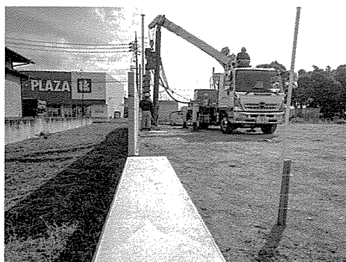
第275図版 調査状況（西から）
