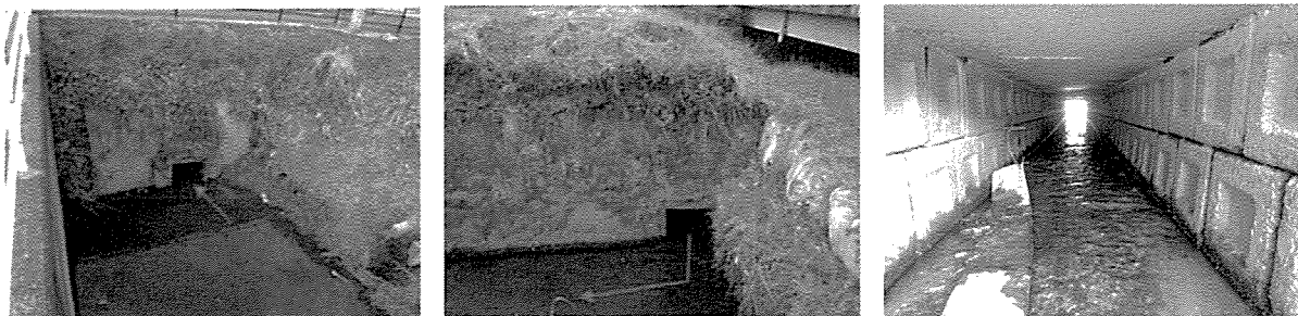
第318図版 辛樋の現況 左：呑口（南から） 中：吐口（北から） 右：内空（南から）
