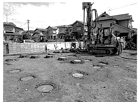
第400図版 工事施工状況（南西から）
