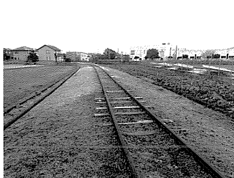
第249図版 引込線の現状（南西から） 2021年12月
