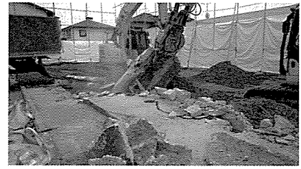
第166図版 作業状況(西から)
