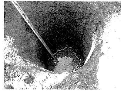
第96図版 電柱の据え付け穴の 完掘 (東から)
