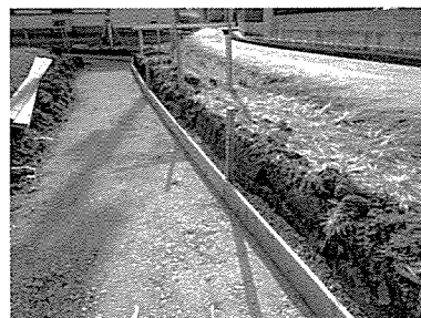
第229図版 西擁壁(北から)
