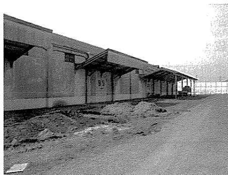
第250図版 倉庫の底の現状 2011年4月（南から）
