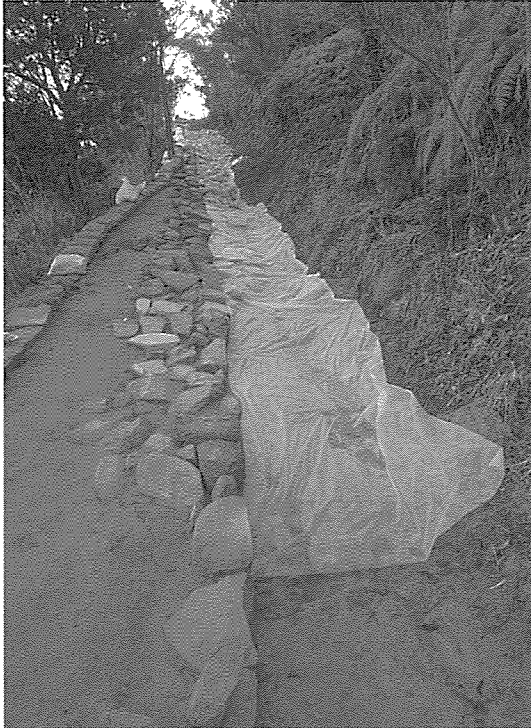
第126図版 不織布の設置状況（北から）
