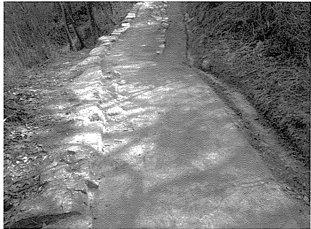
第123図版 第1水門内側の捨石群の工事終了後 (南から)
