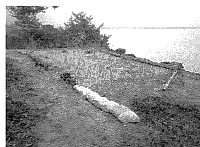
第132図版 高石垣の保護作業
