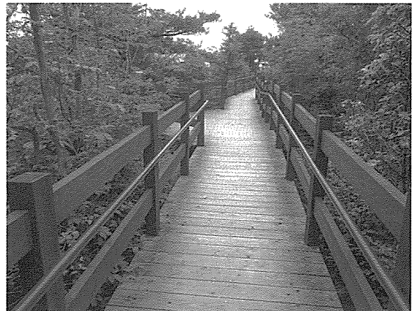
左・施工前 右：施工後
