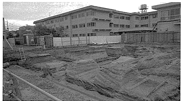
第41図版 調査地近景 (北西から)
