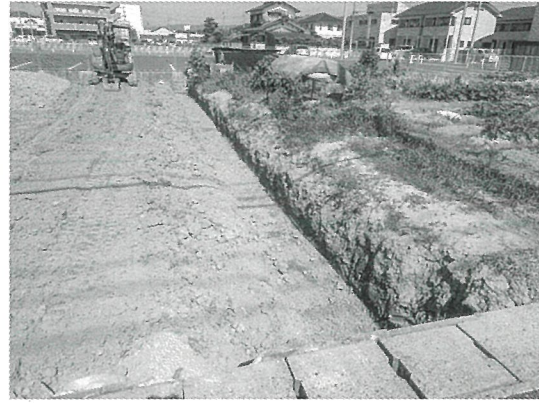
第2図版 ② 調査状況（東から）
