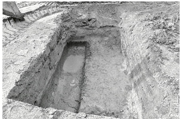
第42図版 2 トレンチ掘削状況
