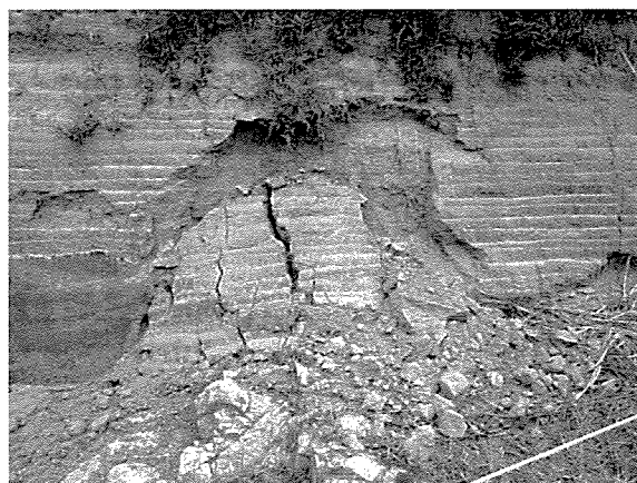
高さ1.5 m, 幅1.8 m, 厚さ20cmで表面崩落
