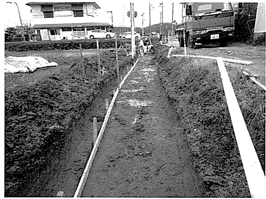
第109図版 調査状況（北から）
