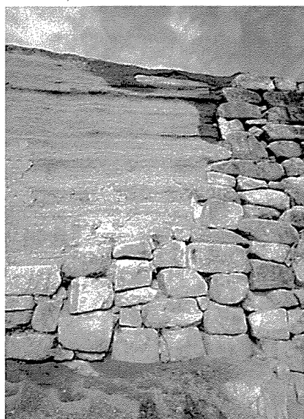
第112図版 左：⑤高石垣北側の復元版築土塁 右上：拡大 右下：補修状況（布）
