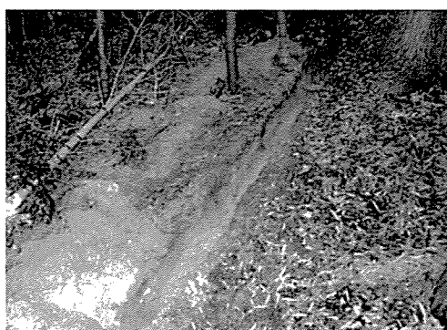
第43図版 掘削状況
