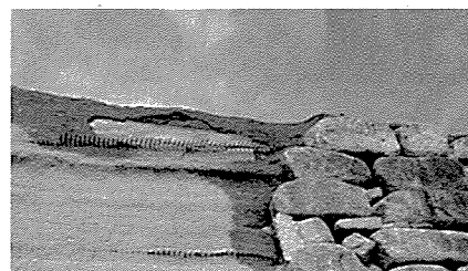
第112図版 左：⑤高石垣北側の復元版築土塁 右上：拡大 右下：補修状況（布）
