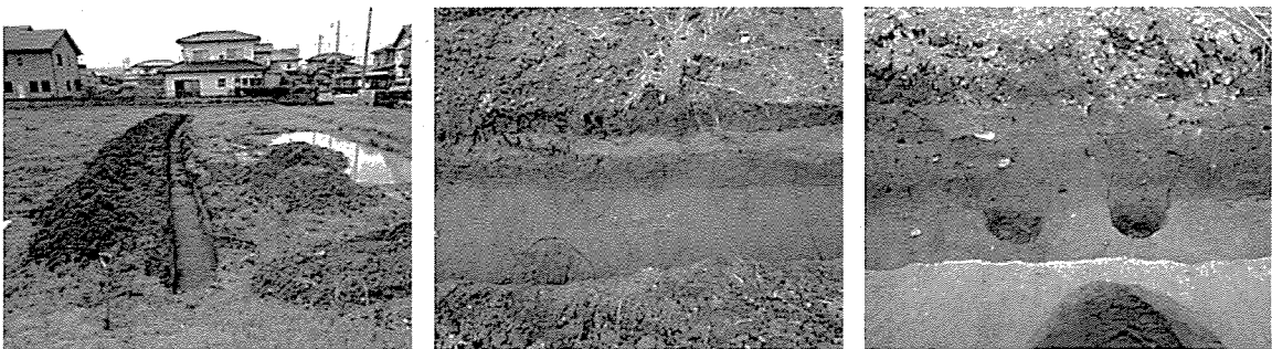
第31図版 調査の状況
