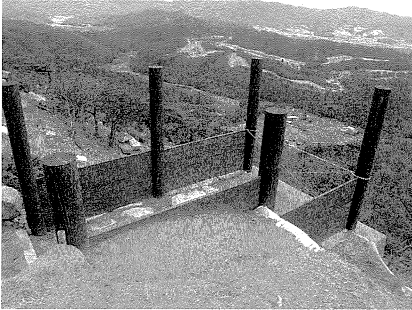
第 85 図版 東門の柱立てと板塀 (南西から)
