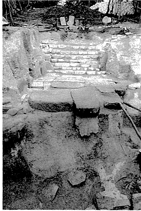
第26図版 正面側からみた南門跡
