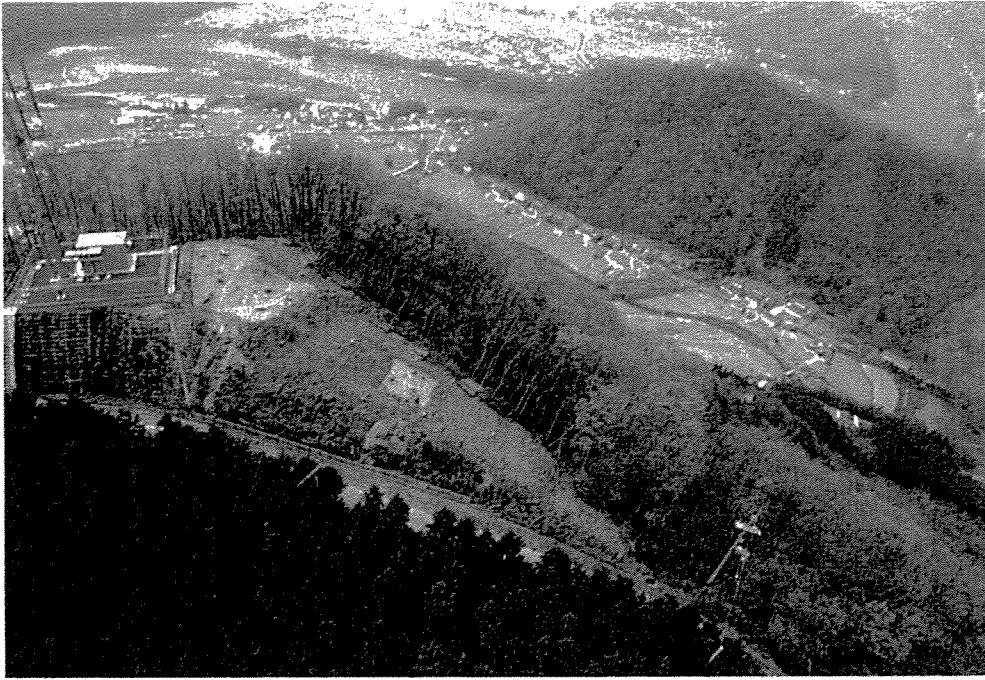
第1図版 調査地全景
