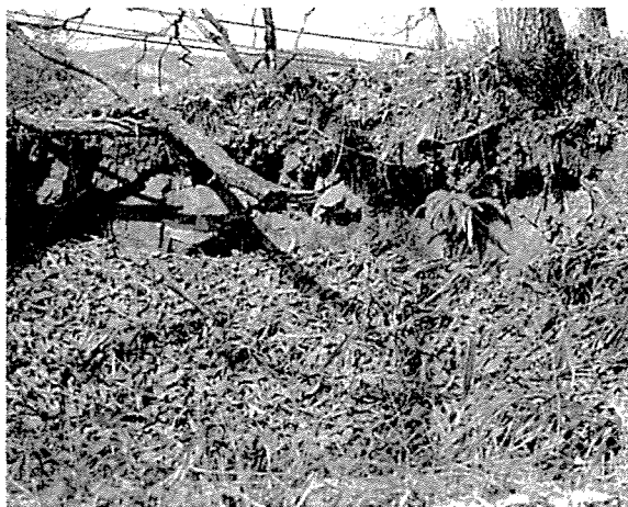
第60図版 崩落箇所
