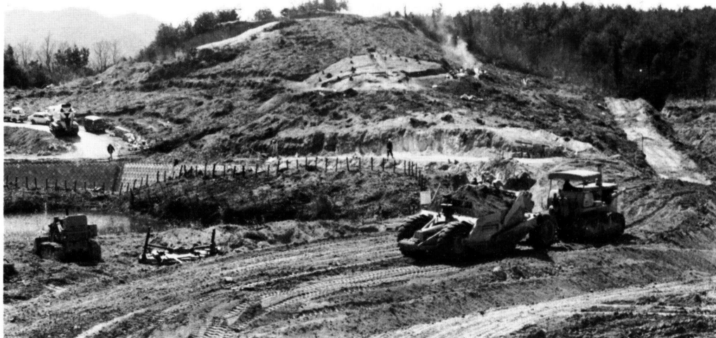
1. 掘り上がり後の遠景（北から）
