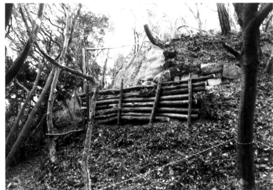
第39図版 遺構の保護処置
