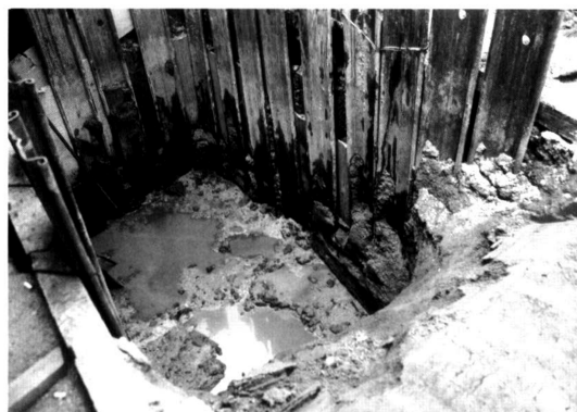
第11図版 掘削部（南東から）
