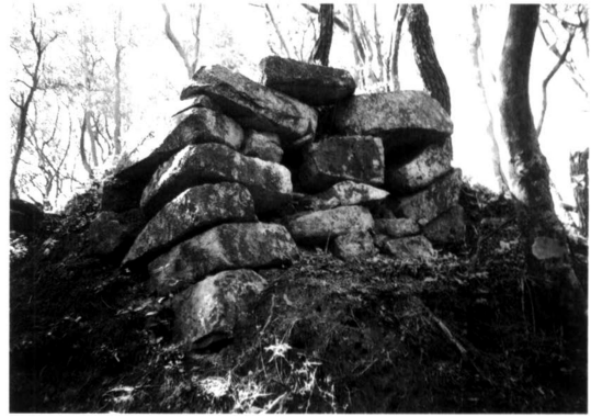
1. 崩壊前の石垣
