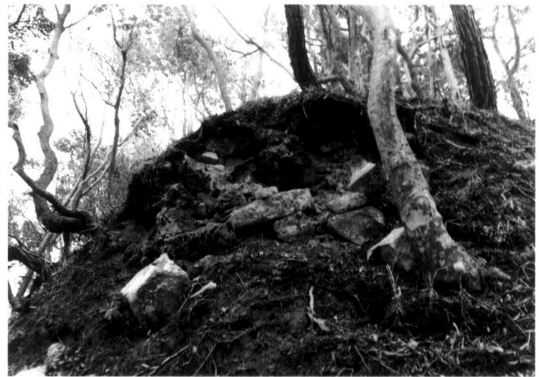
2. 崩壊後の石垣
