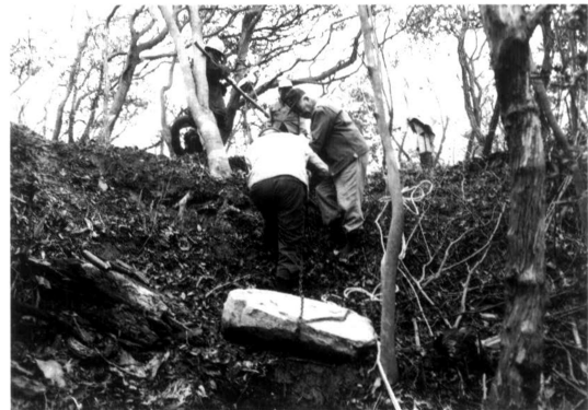
第38図版 築石の引上げ作業
