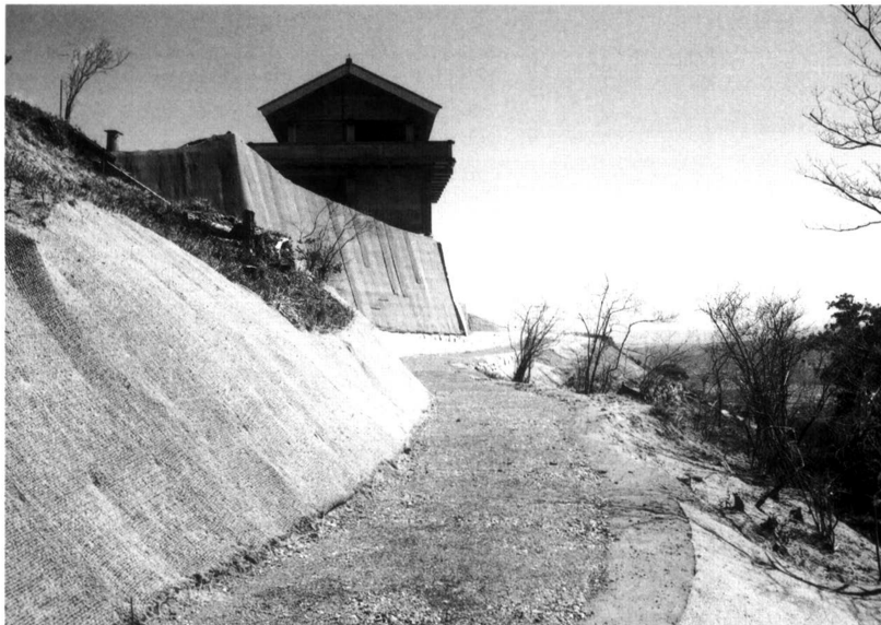
第29図版 西門・角楼間の土塁と園路
