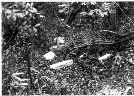
第34図版 築石転落状況
