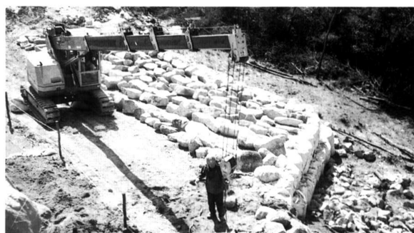
第38図版 石材引き上げ
