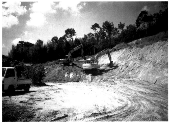
第16図版 工事状況
