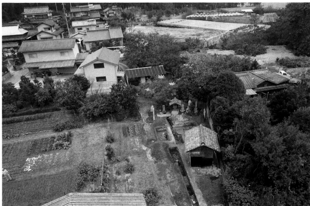
2. 調査区近景（南から）
