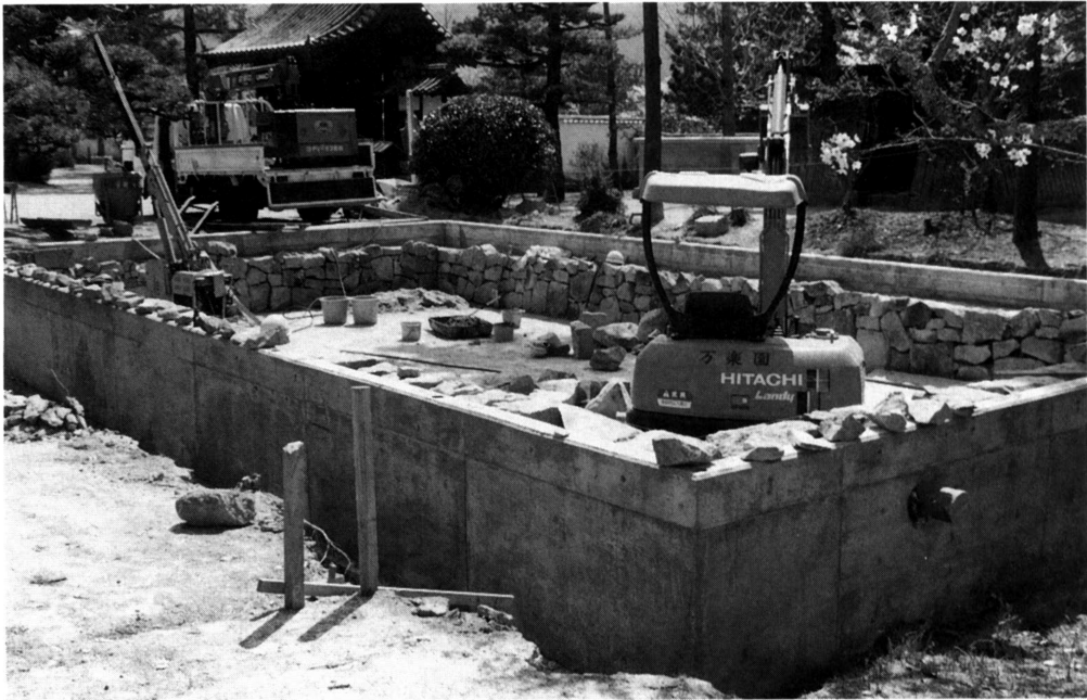
第1図版 工事状況
