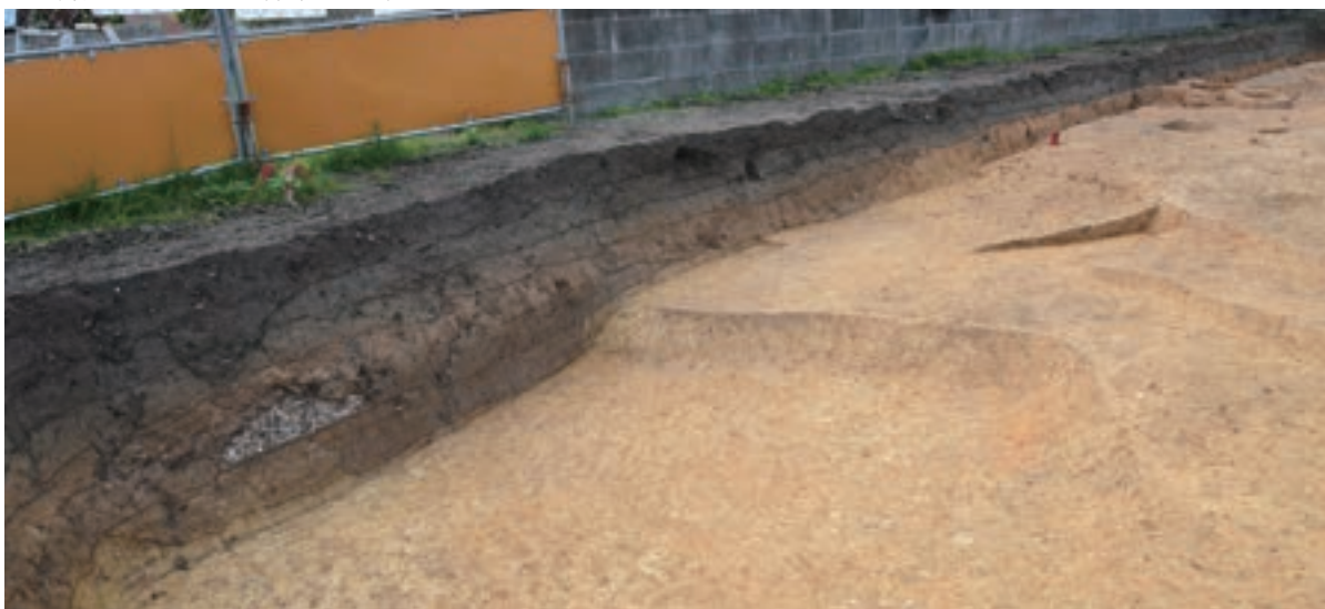
2 調査区西半部北西壁土層断面 (南から)
