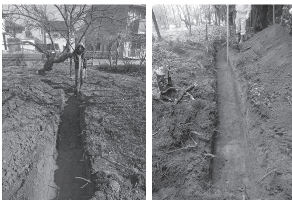
写真2 T2確認調査状況 写真3 T11確認調査状況
