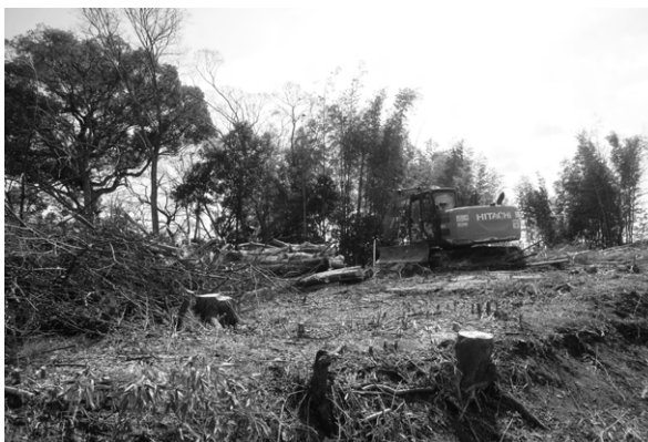
写真4 樹木伐採作業状況（北から）
