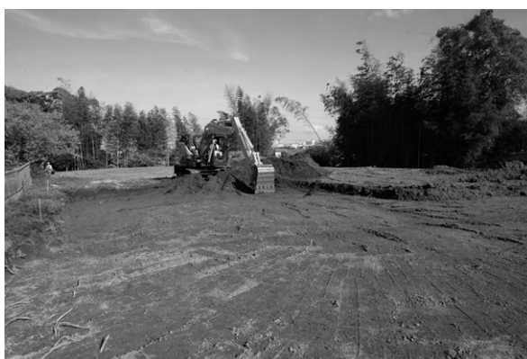
写真5 表土掘削作業状況（西から）
