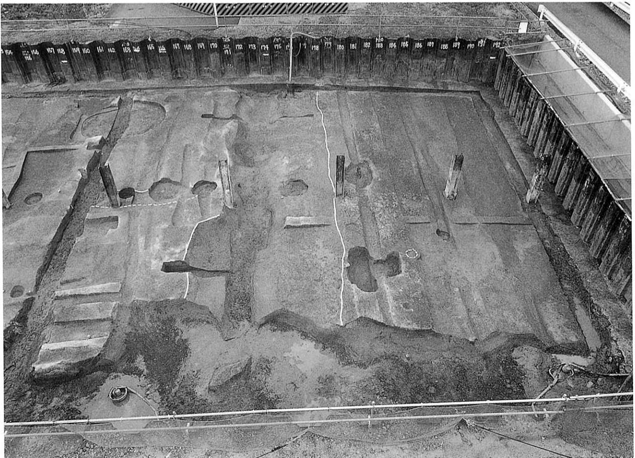
2 98-2-V区 第5-1面全景(東から)
