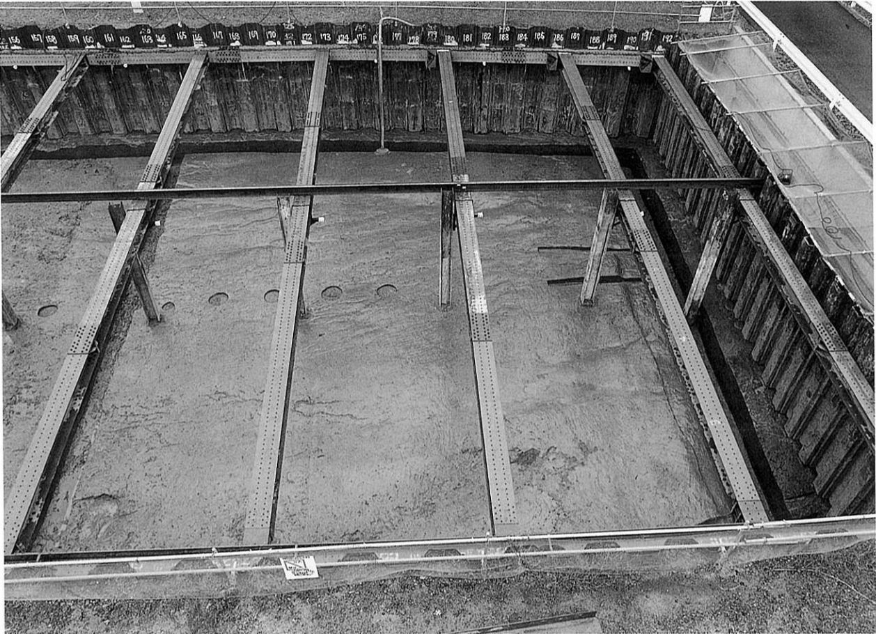
1 98-2-V区 第6面全景(東から)
