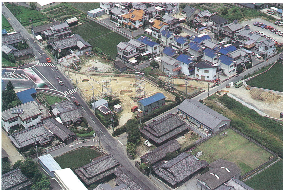
A・B地区航空写真（北方から）
