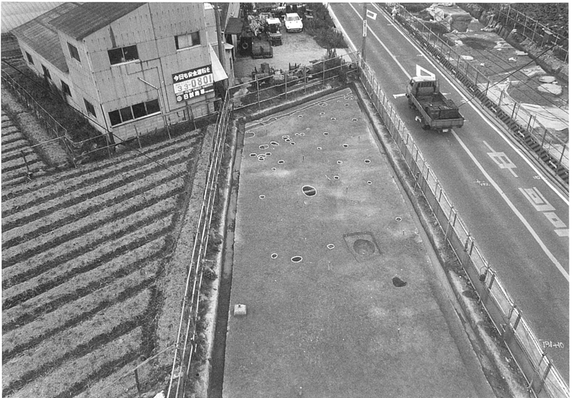
ⅢA区 東半部全景（北西より）
