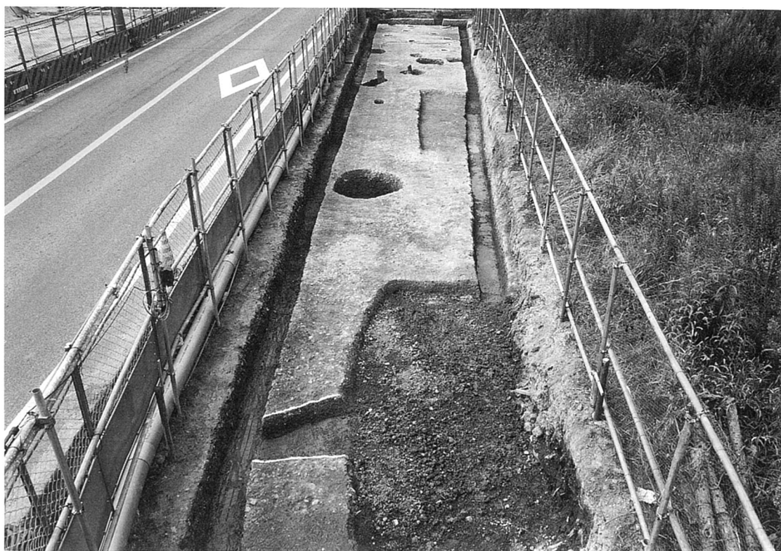
ⅢC区 全景（南東より）
