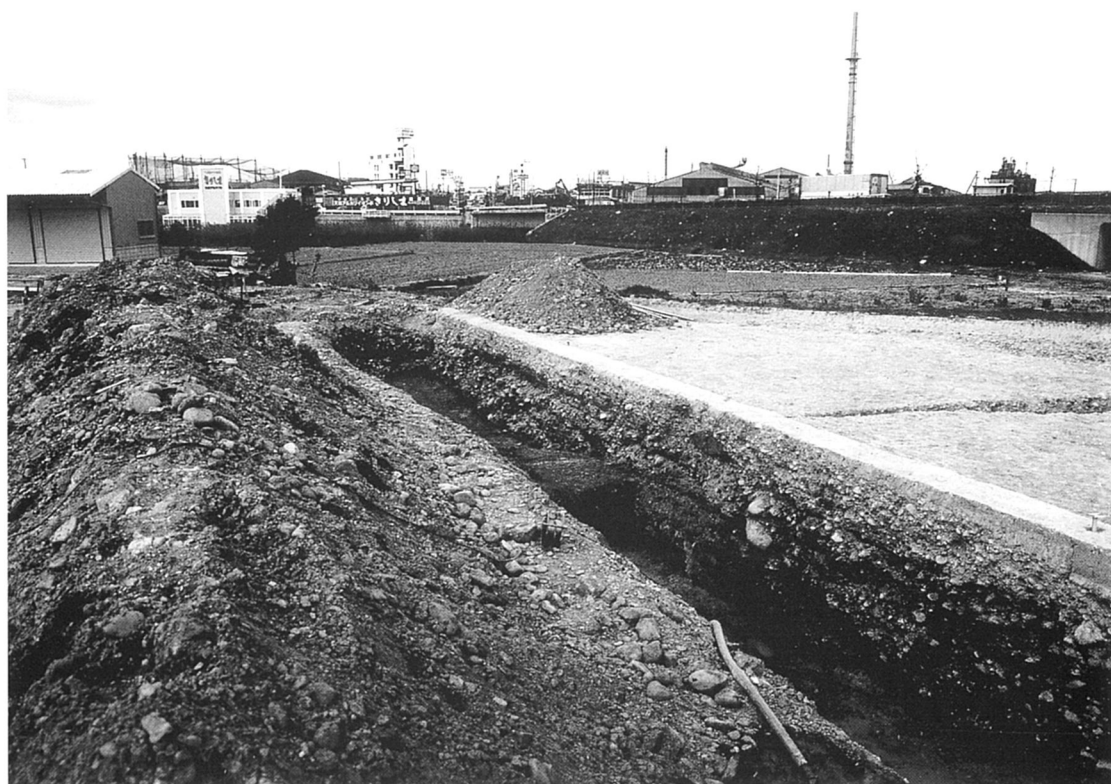
第1トレンチ全景（東より）
