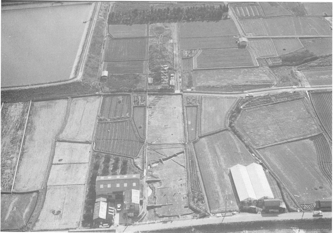
調査地全景 (北から)
