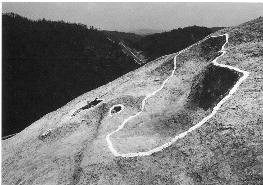
a. B地区 土城10.11 219-O X・217-O O (西から)
