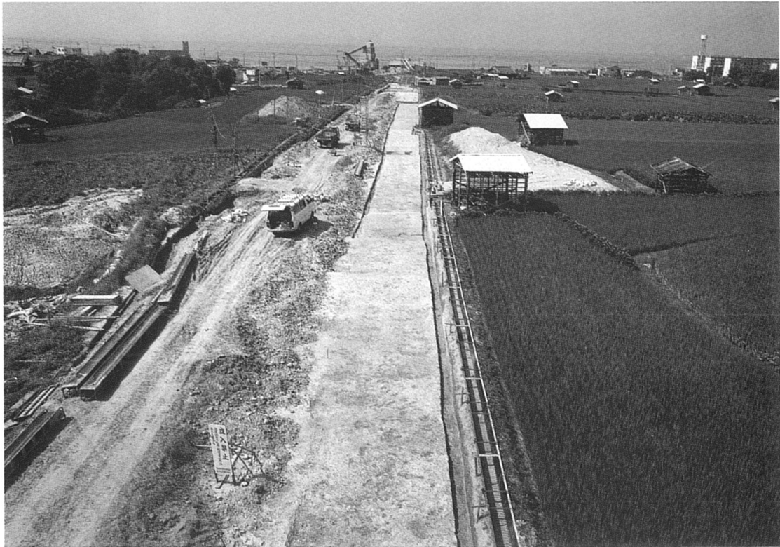
Ⅱ区全景（南東から）
