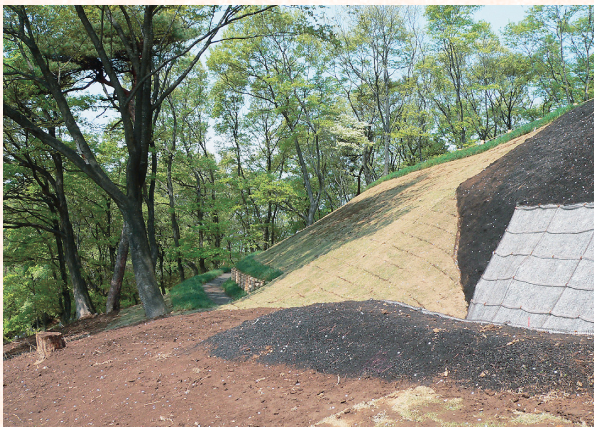
見附出丸・南土塁下のジオファイバー工法
