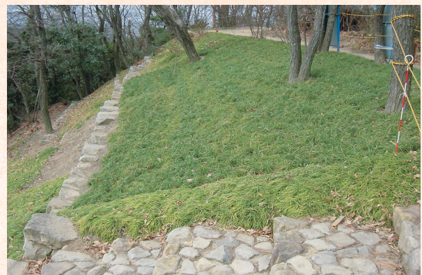
西矢倉台通路脇・法面の植栽工事
