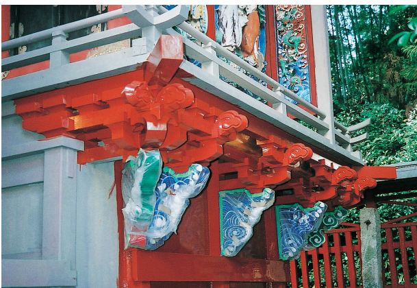
修復作業中の冠稲荷神社本殿
