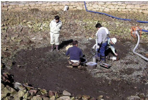
日ノ池は、金山城跡を代表する景観のひとつです。池の底には、史跡整備の過程で木炭浄化装置を設置し、恒常に水質の維持を図っています。この装置は平成8年に設置されて以来、常時稼動させてきた水中ポンプですが、老朽化により使用不能となっていました。そこで、機器を更新するとともに、装置全般の点検を行い、併せて不要な藻類を除去しました。なお作業に当たって、一時的に池の水をすべて抜き取りましたが、終了後は再び、雨水と周りから差して来る水で満たされて行きました。
