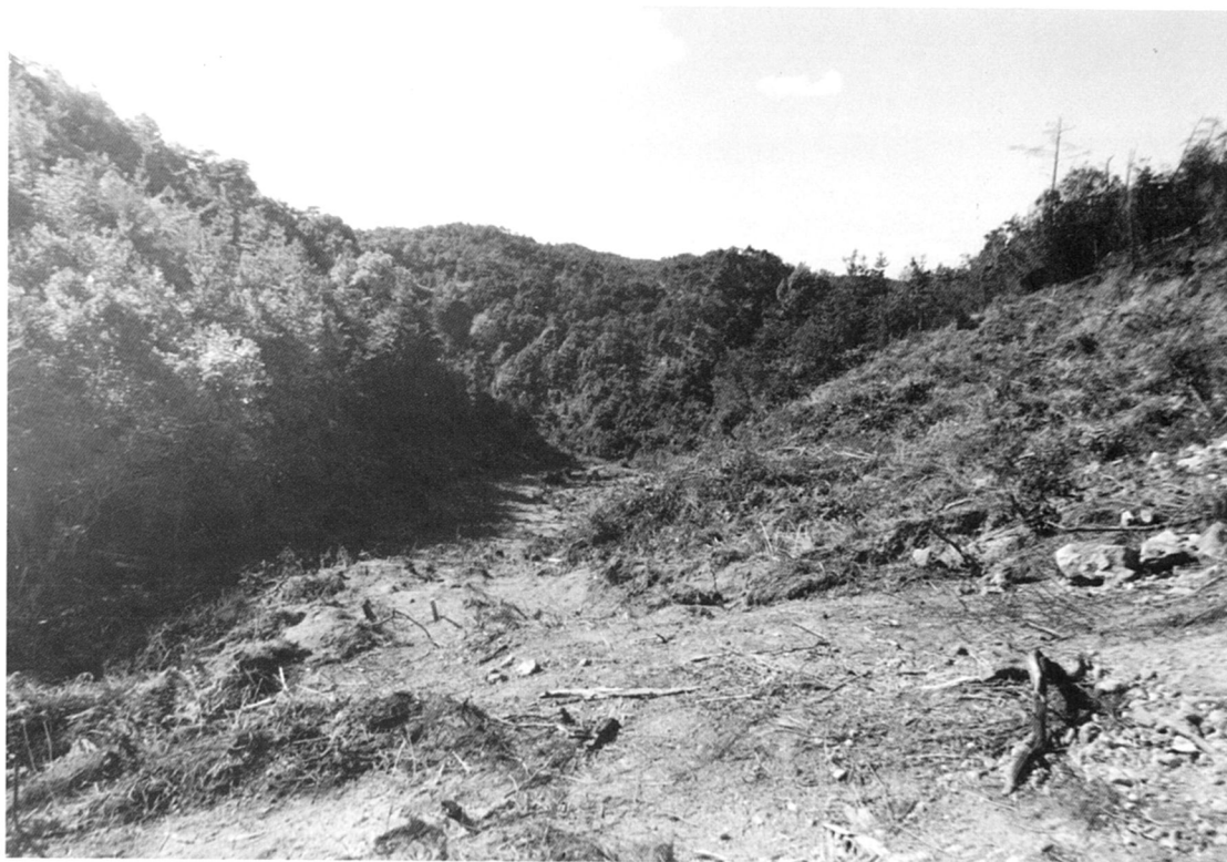
第6～8トレンチ遠景
