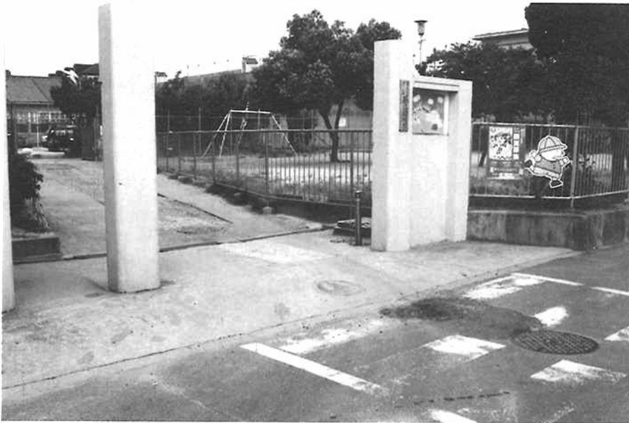
図333 若江幼稚園 正門付近 (南東から)
