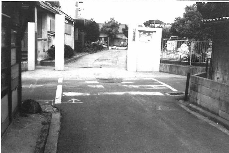
図334 若江幼稚園 正門付近 (東から)
