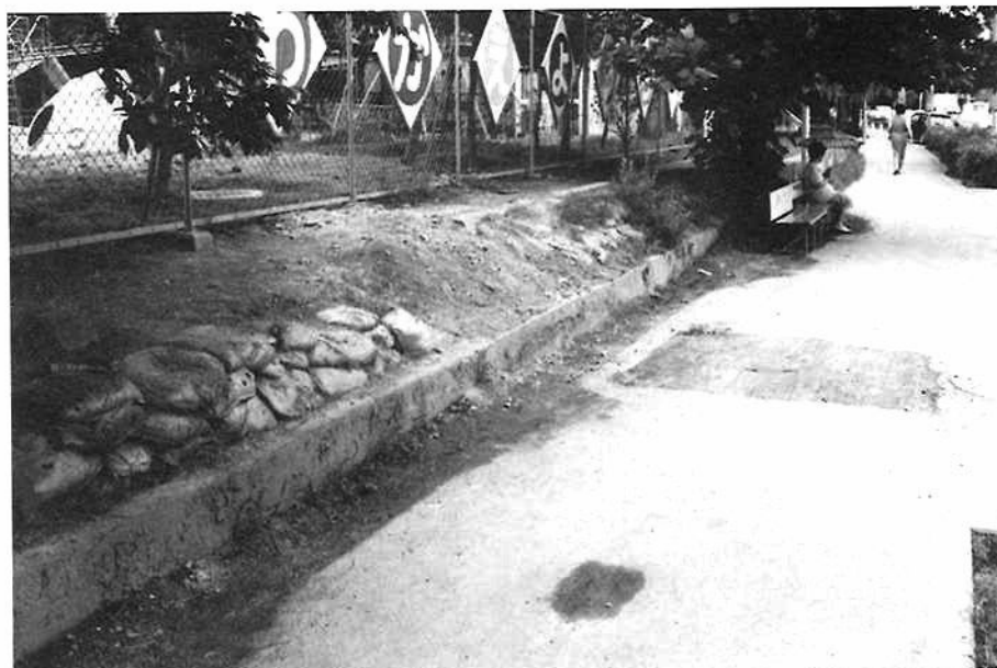
図329 若江幼稚園 と府道の段差 (西から)
