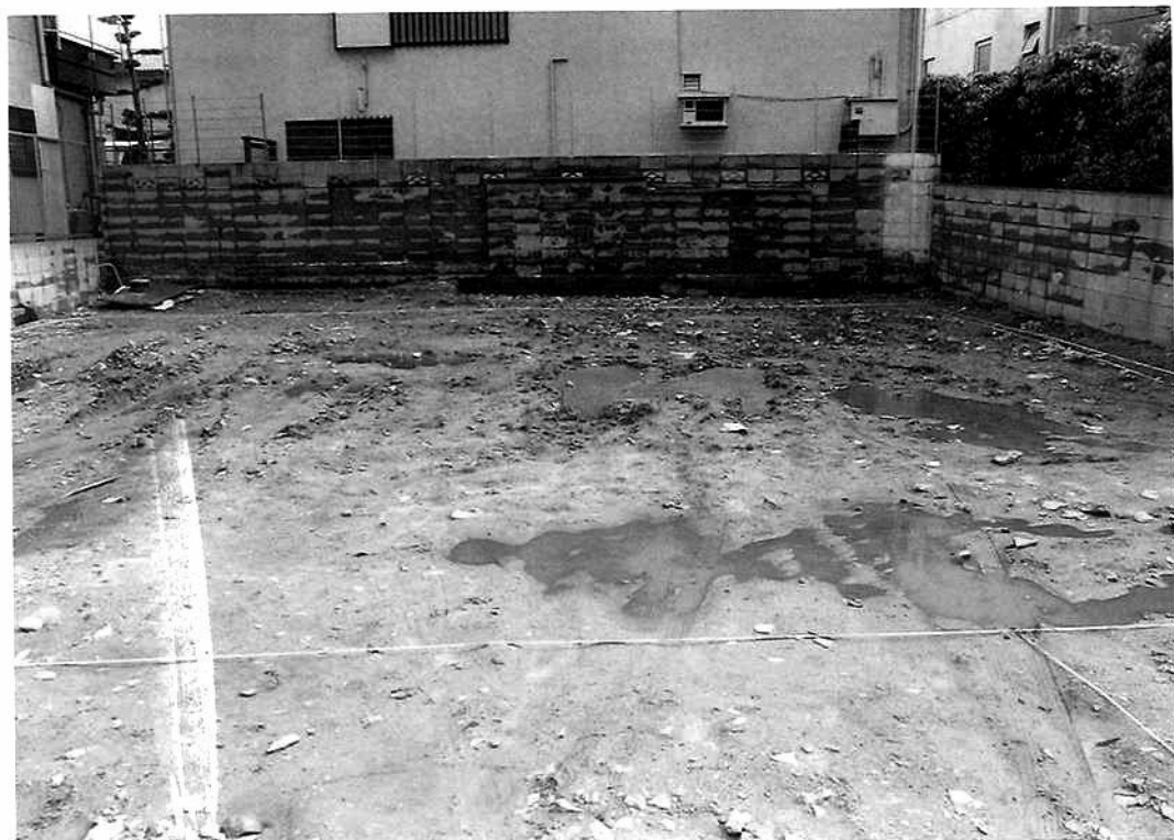
1. 調査前の状況
