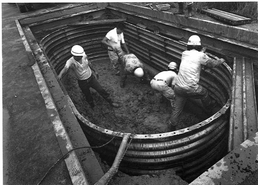
2. A地区ライナープレート設置風景
