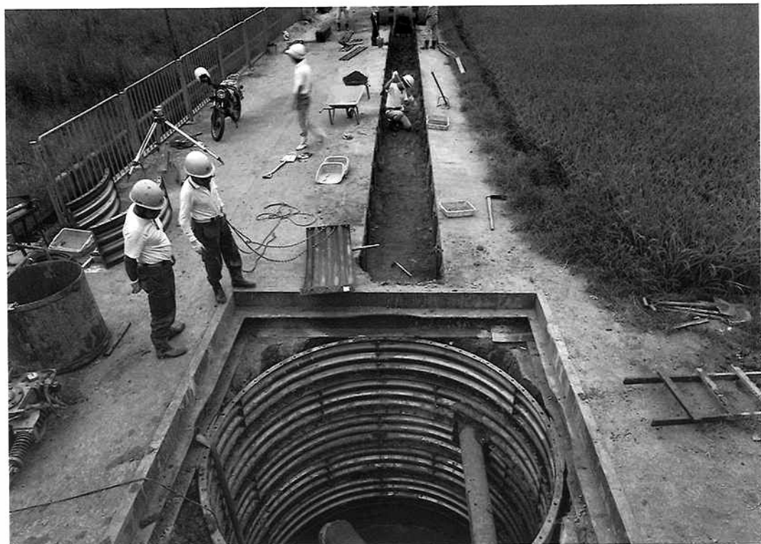
1. B地区作業風景
