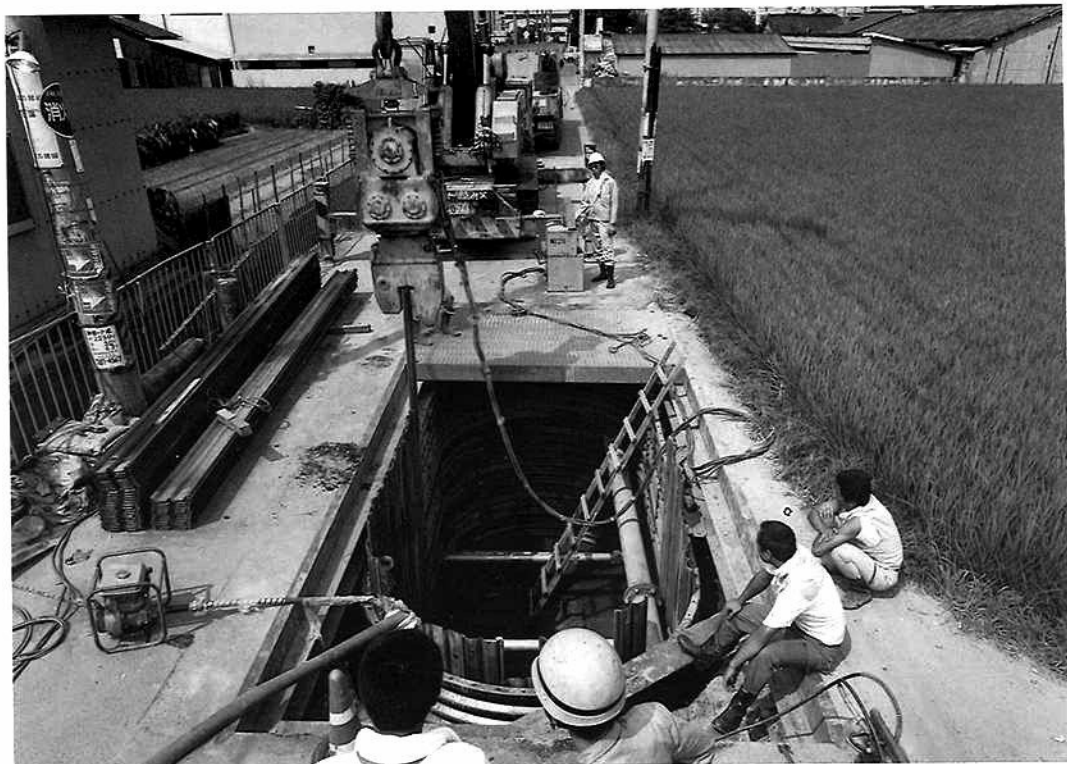
1. A地区作業風景
