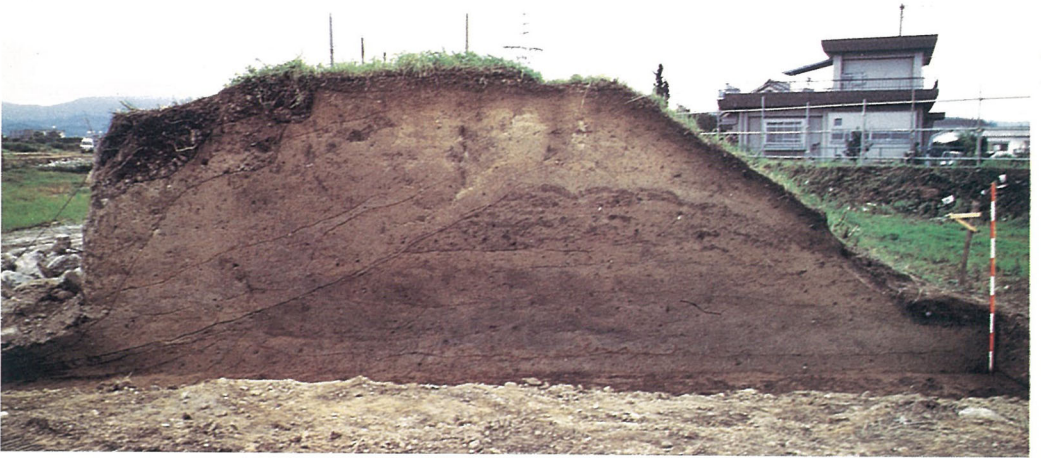
コモ池堤防断面（北から）
