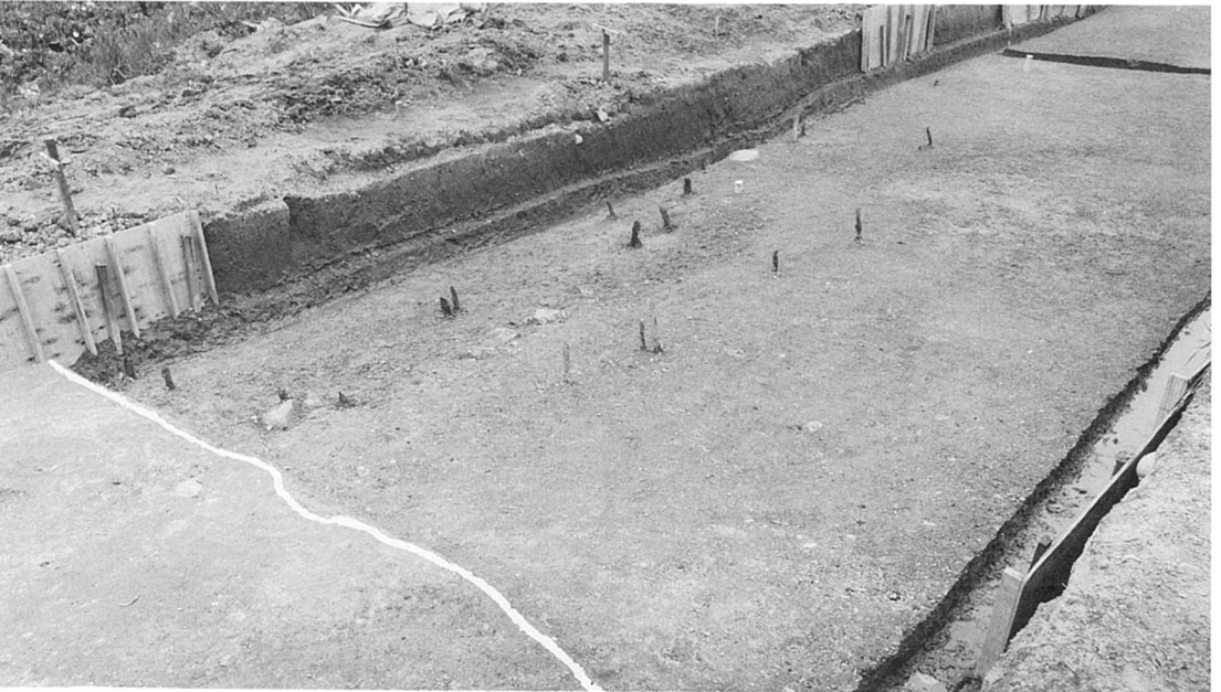
段と谷地形内の木杭
