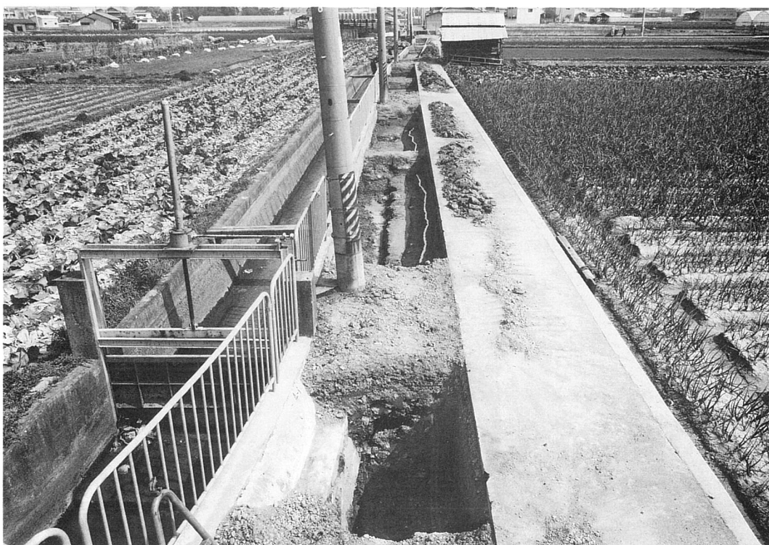
(2) 第4区全景(西から)
