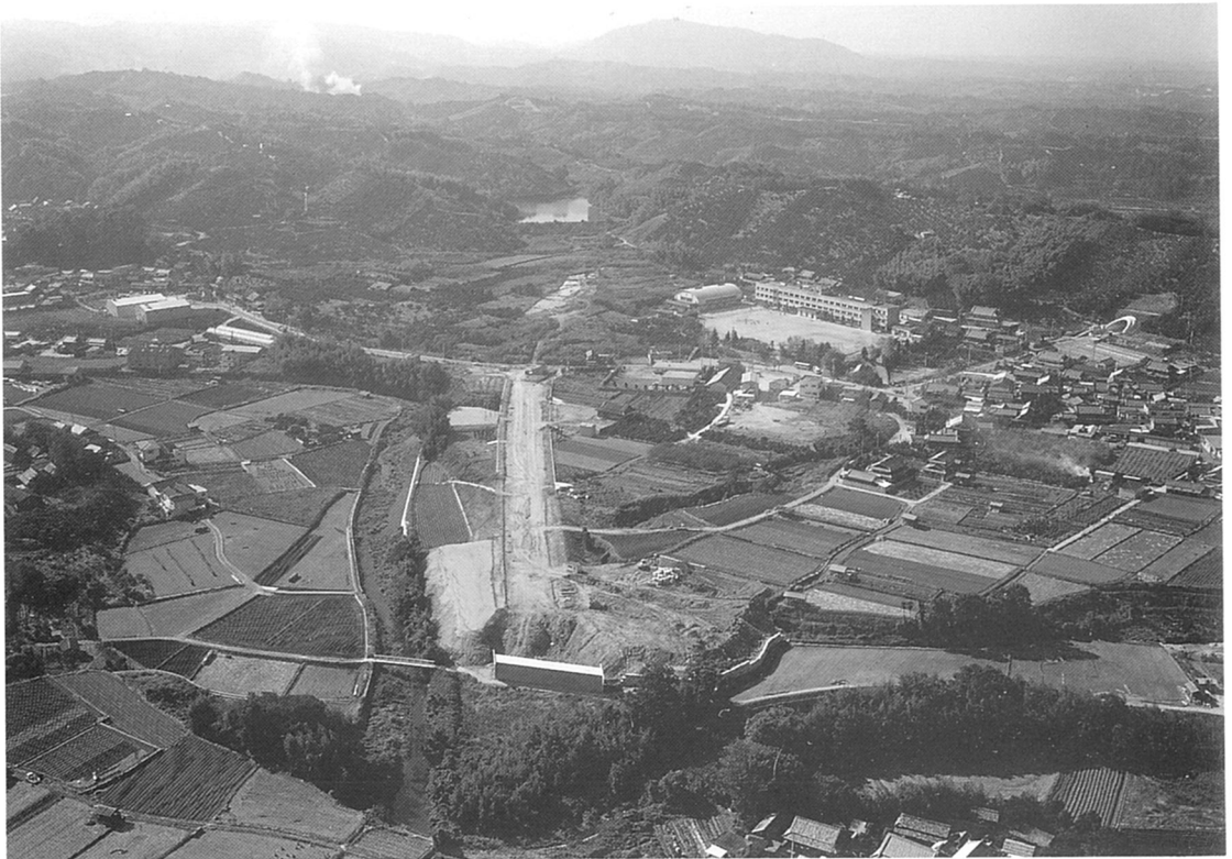
調査区遠景（東から）
