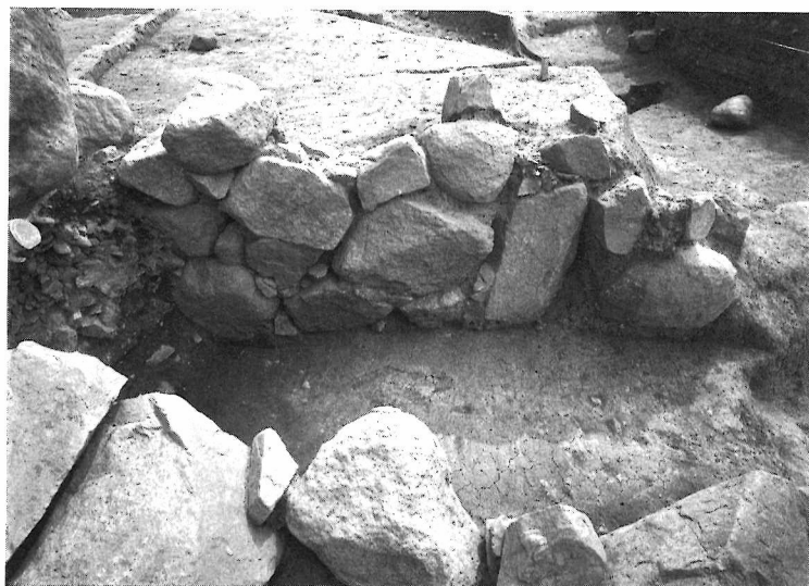
写真19 出雲井4号墳 の羨道部分の東側壁
