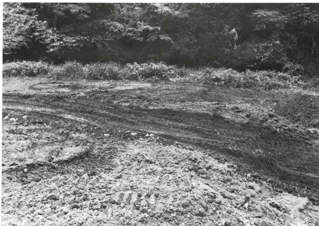
▼ 2 埋め戻し完了
