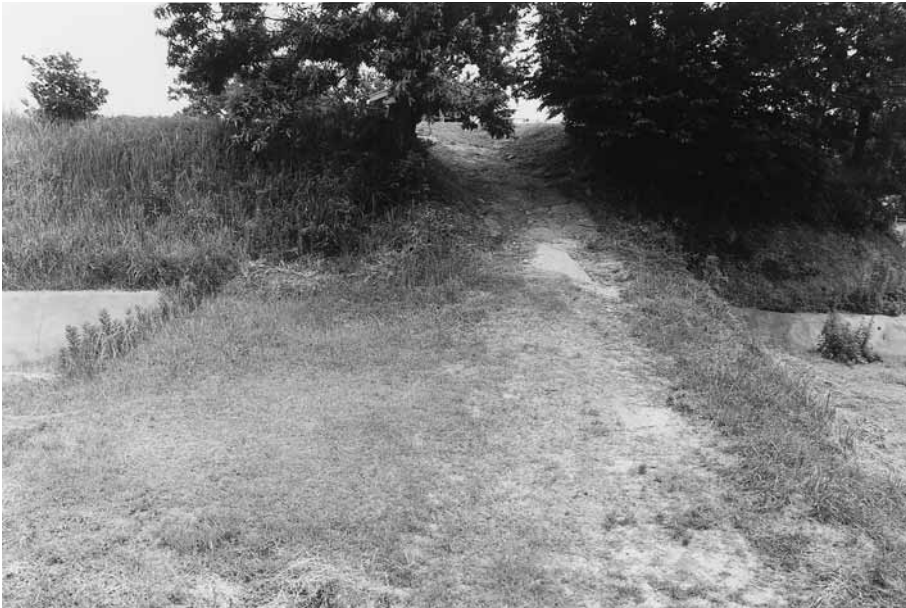
T 1803調査前状況 (南より)
