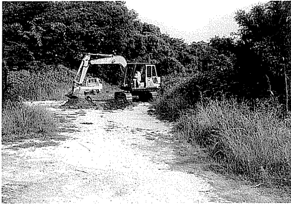
T1501表土除去状況（南より）
