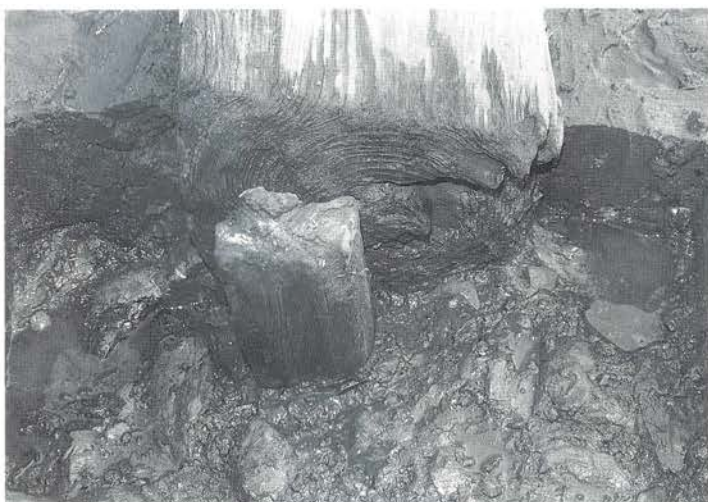
◀ 3. 北隅に打ち込まれた杭と 1期池底の上に据えられて いる基礎材
