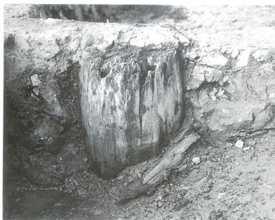
▲ 3. II-2期に埋め込まれたII-1期汀線と中央の橋脚
