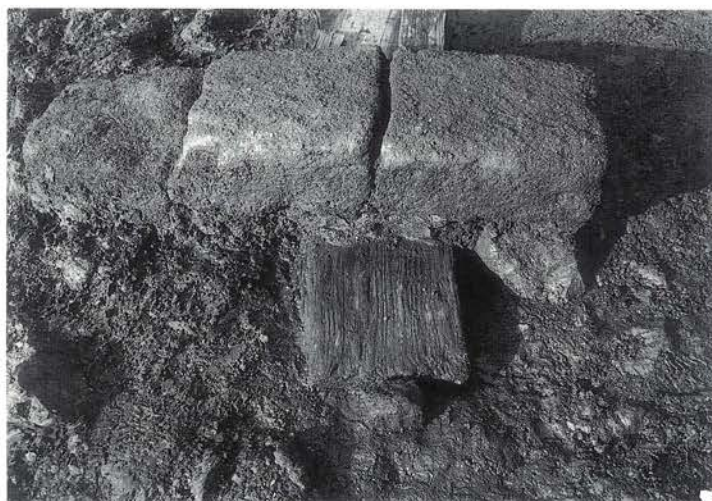
▶ 2. 南隅に打ち込まれている 杭と上にある鎌倉石
