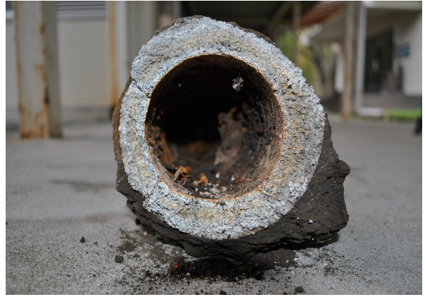
図版16 九五式演習弾 コンクリート部分(固定用の釘が見える)
