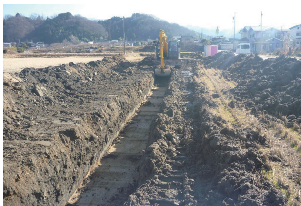
図38 トレンチ調査風景 (1T)
