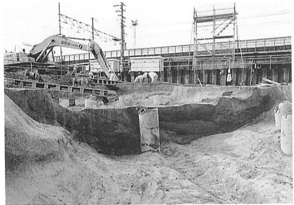
4. 第C-6面 溝C-601断面 No. 3 (東から)
