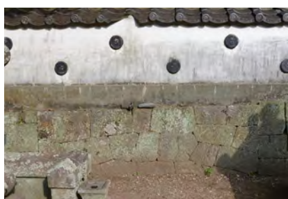
写真3-5 北面内周石垣旧開口部
