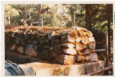
写真3-3 東面石垣上部修理状況
