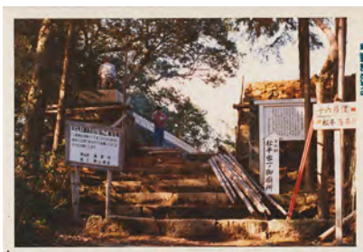
写真3-1 門周辺修理状況
