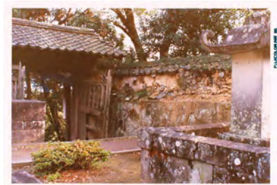
写真3-2 門周辺修理状況
