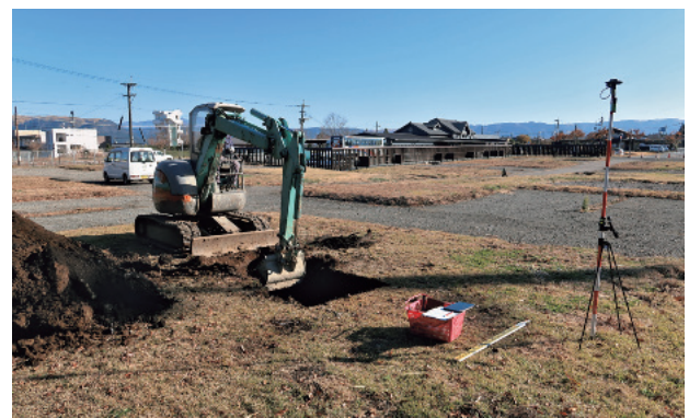
図-4 トレンチ掘削の様子
