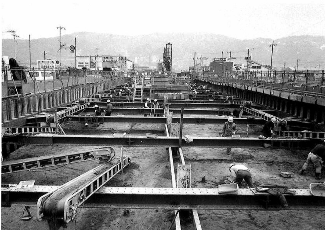
2. A地区 調査作業風景（西より）
