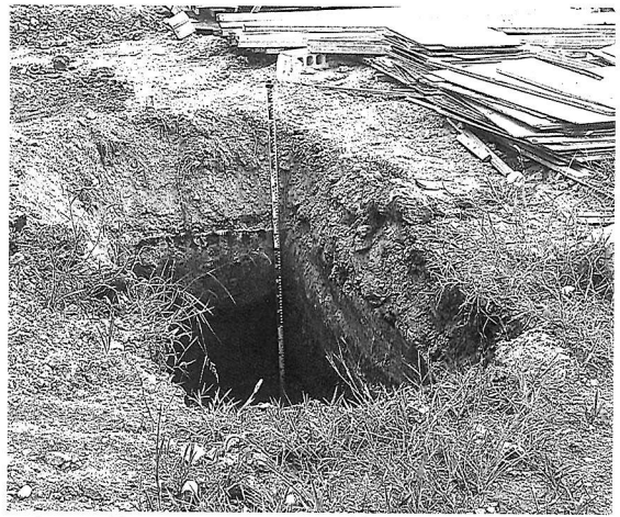
写真5 第11トレンチの掘削終了状況。北から南を撮影。工場の基礎と盛土。
