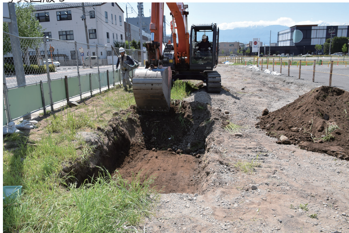
調査開始 A区(東から)
